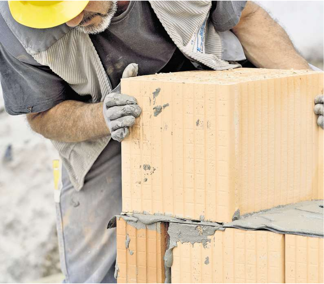
Bauhandwerk. Foto: www.amh-online.de
