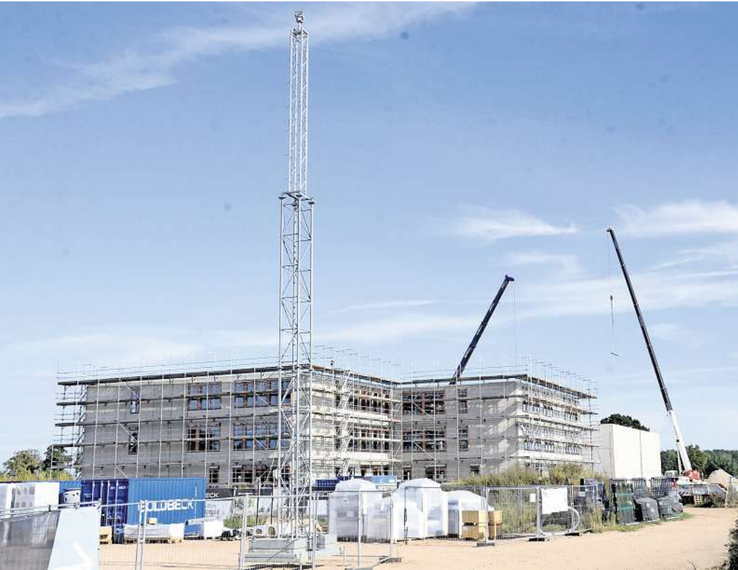
Im zweiten Bauabschnitt entsteht an der Bundesstraße B 191 ein Linksabbiegestreifen in die Stichstraße zur neuen Schule, die derzeit gebaut wird. Foto: Müller
