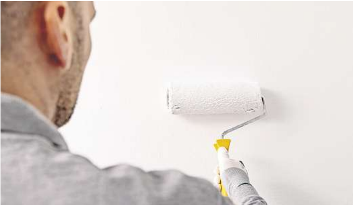
Die abwaschbaren Wandfarben werden so wie übliche Dispersionsfarben mit der Rolle aufgetragen.
