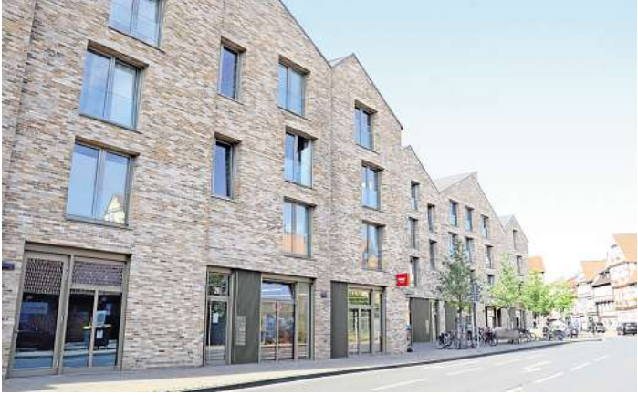
Die Situation rund um den Gebäudekomplex Village an der Ecke Bergstraße/Wehlstraße in Celle stand erneut im Mittelpunkt der Ortsratsitzung Blumlage.
