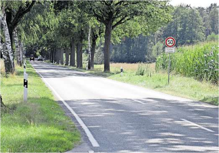
Auch auf der Landesstraße 283 werden an einigen Stellen Arbeiten vorgenommen.
