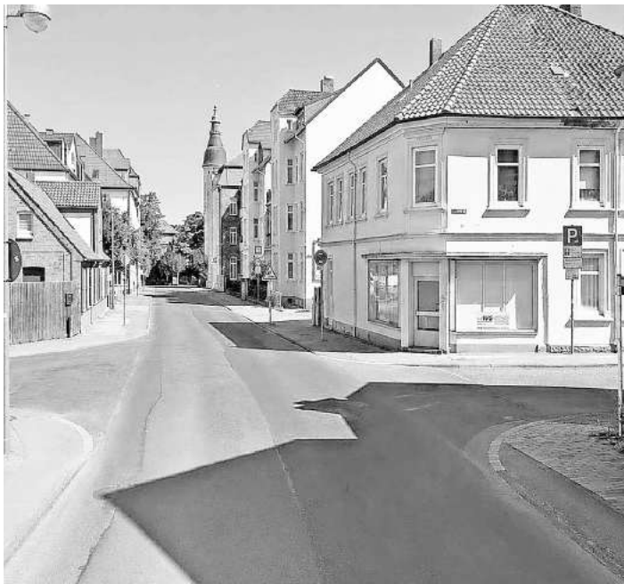
Die Fuhsestraße wird saniert. Foto: Stadt Celle
