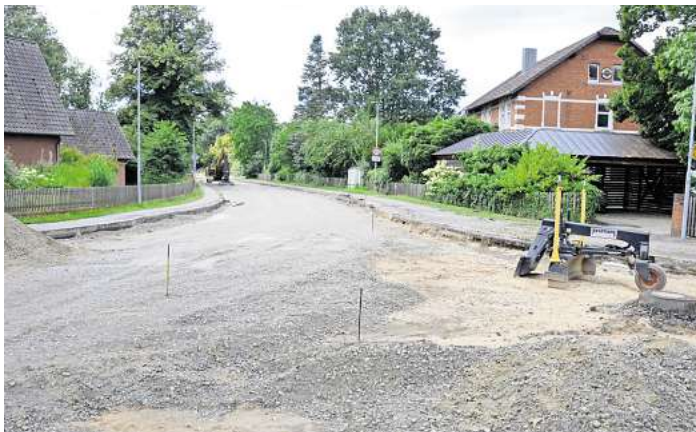
Noch befinden sich die Arbeiten an der Ortsdurchfahrt Beedenbostel im ersten von drei Bauabschnitten. Foto: Müller
