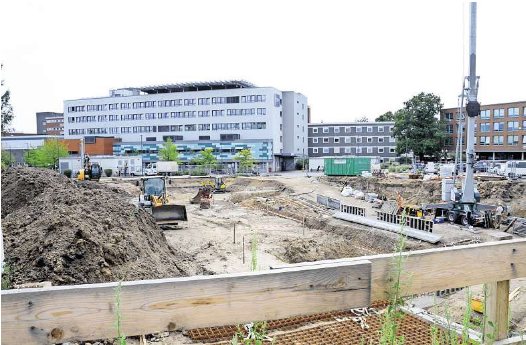
Die Baugrube für das AKH-Parkhaus. Foto: Müller
