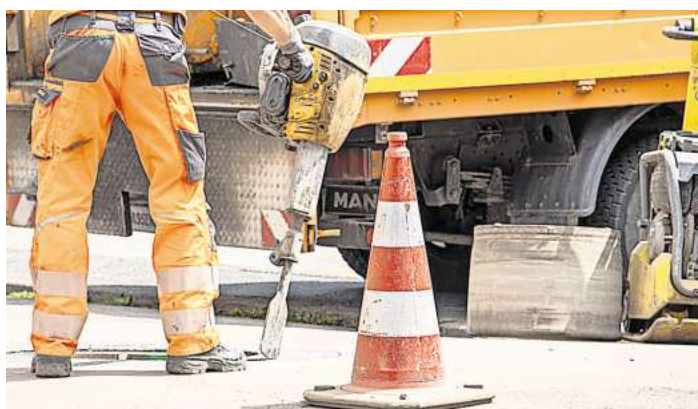
Arbeiten im Hehlenbruchweg.
