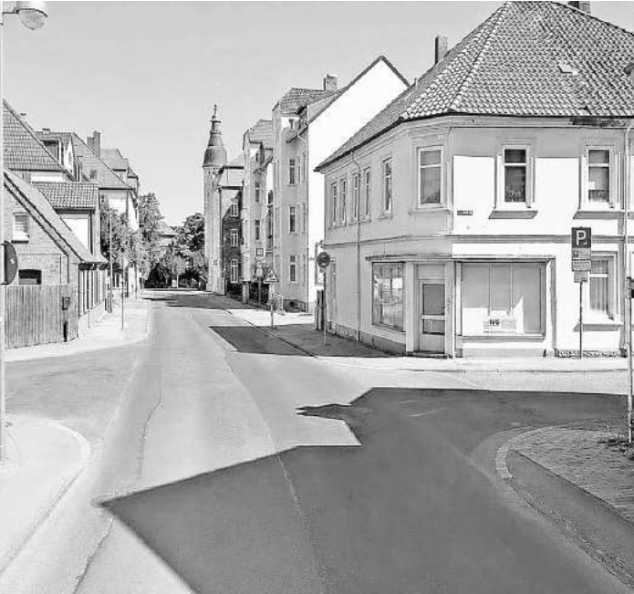
Die Fuhsestraße wird saniert. Foto: Stadt Celle
