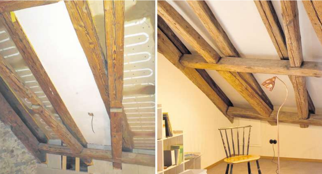
Mit Lehm-Klimaplatten als Flächenheizung und -kühlung lassen sich Dachgeschosse ganzjährig angenehm klimatisieren. Den Einbau können versierte Heimwerker sogar selbst vornehmen. Foto: DJD/naturbo
