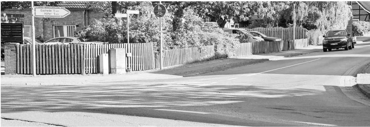
Die Ortsdurchfahrt Beedenbostel wird saniert.
