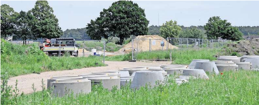
Auch in Garßen entsteht eine Grundschule. Foto: Müller
