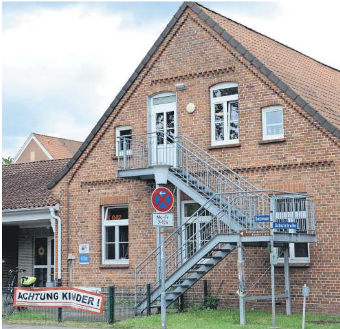
Für die Sanierung der DRK-Kita "Kinnerhus" gibt es eine Kreiszufwendung. Foto: Müller
