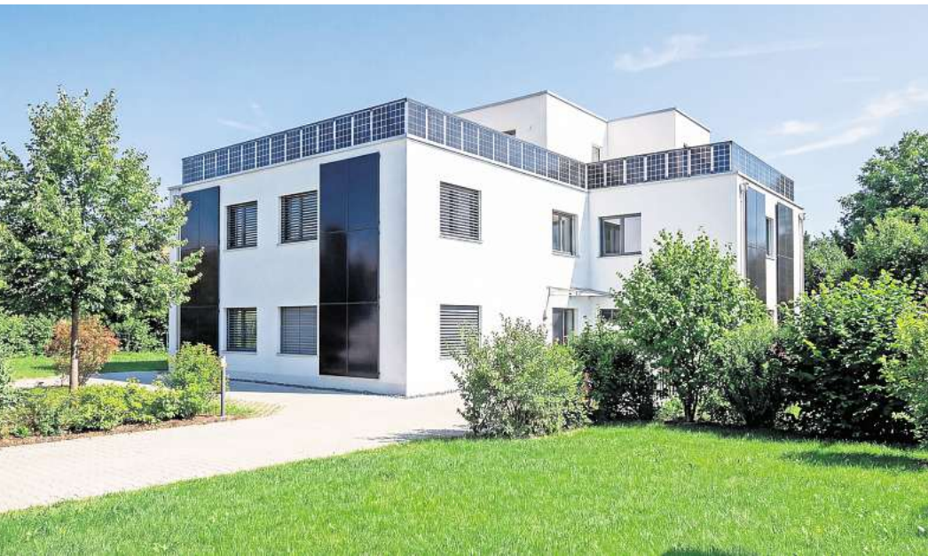
Ansprechende Optik mit Zusatznutzen: Solarelemente an der Fassade liefern Ökostrom frei Haus. Foto: DJD/Solarterrassen & Carportwerk/www.premium-solarglas.com
