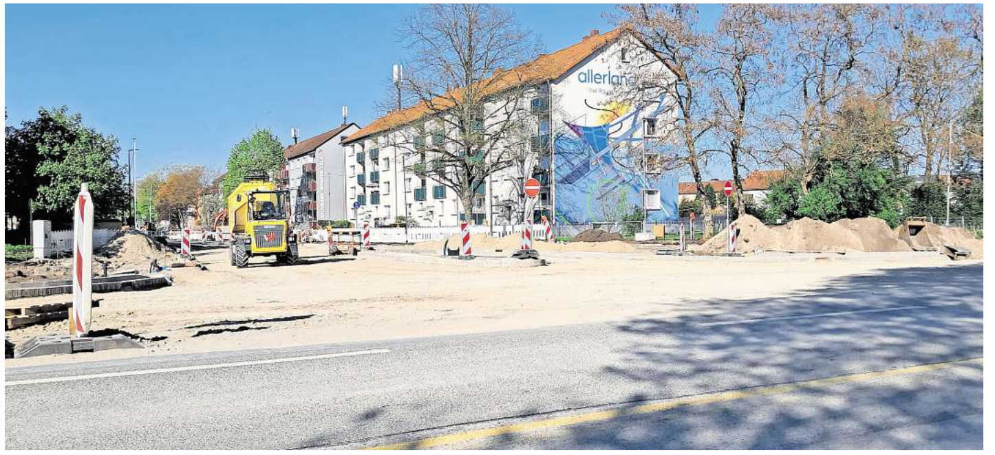
Die Welfenallee, Einmündung Wilhelm-Heinichen-Ring: Keine Durchfahrt für Busse bis 13. Mai.
