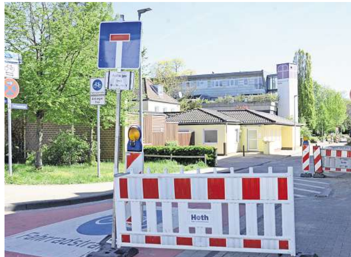
Die Bauarbeiten für die Fritzenwiese sind vorbereitet. Foto: Müller
