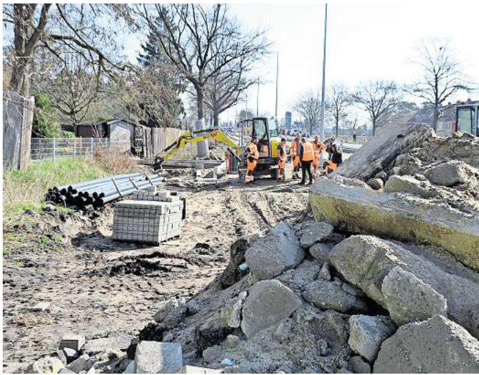
Größtes Infrastrukturprojekt in Celle geht voran. Foto: Kirakossjan
