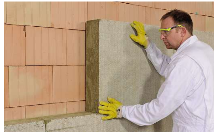
Dämmung wird angebracht.
