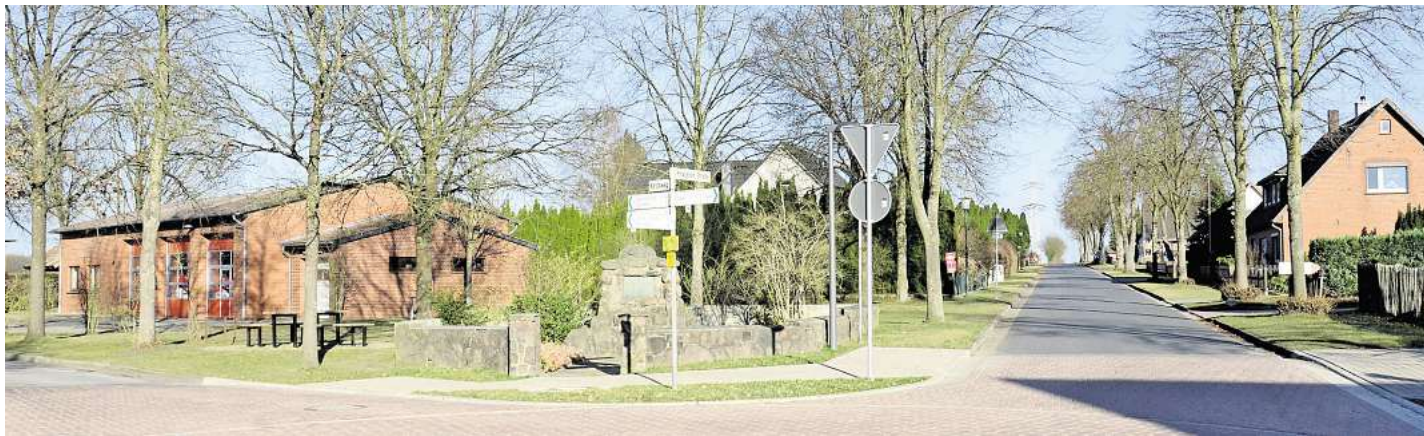
Die Umgestaltung der Habighorster Ortsmitte wurde im Juli 2025 abgeschlossen.
