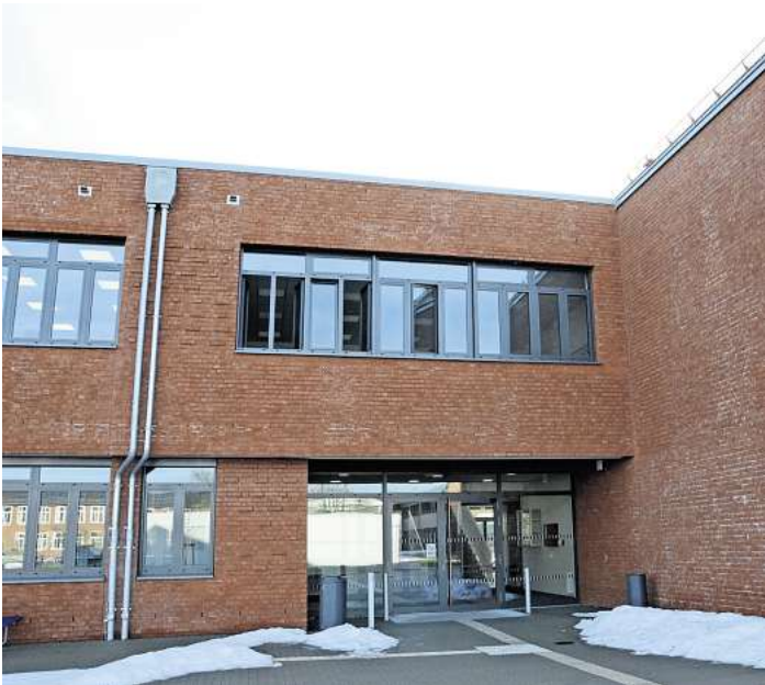
Die Abteilung Sozialpädagogik ist im Neubau untergebracht.
