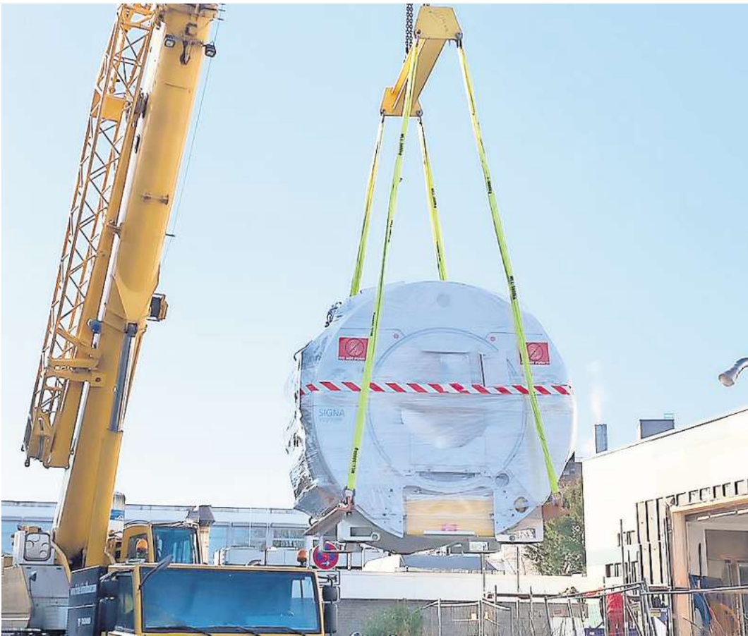
Logistische Präzisionsarbeit: Mithilfe eines Krans wurde das MRT in den neuen Modulbau eingebracht. Foto: AKH Celler
