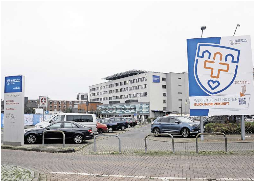
Die Bauarbeiten für das AKH-Parkhaus sollen in diesem Jahr beginnen.
