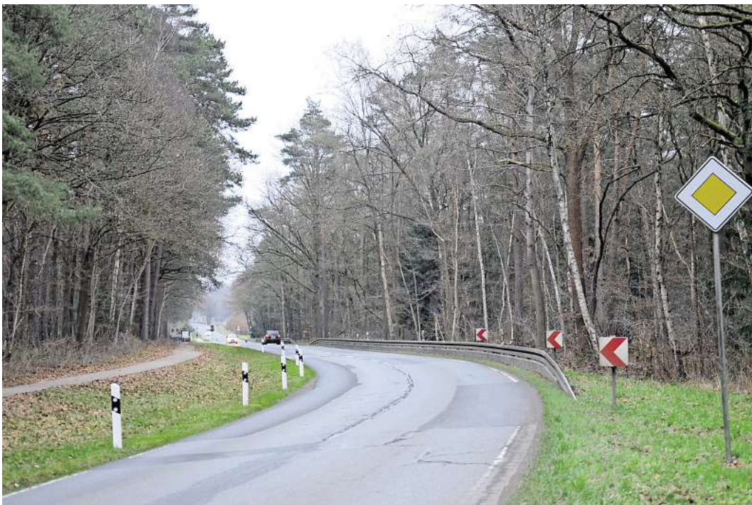
Auf einer Länge von 3,98 Kilometern wird die Fahrbahn zwischen Garßen und Alvern erneuert.
