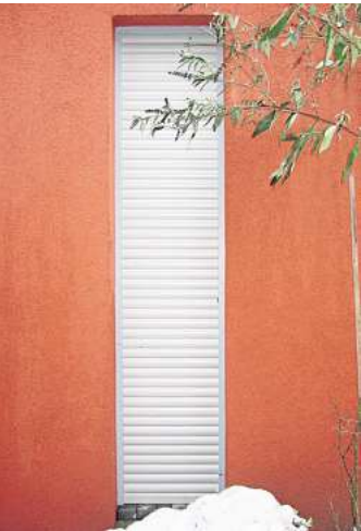
Geschlossene Rollläden wirken wie eine zusätzliche Wärmedämmung - so lässt sich Heizenergie ganz einfach einsparen. Foto: R. Geithe/AdobeStock/BVRS
