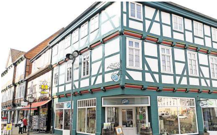
Ansicht einer sanierten Fachwerkfassade am Großen Plan, Erstellungsjahr 2015. Foto: Stadt Celle
