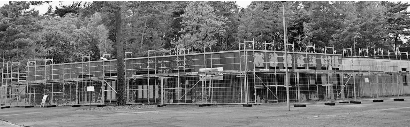
Die Sanierung in der Gedenkstätte Bergen-Belsen ist gestartet.
