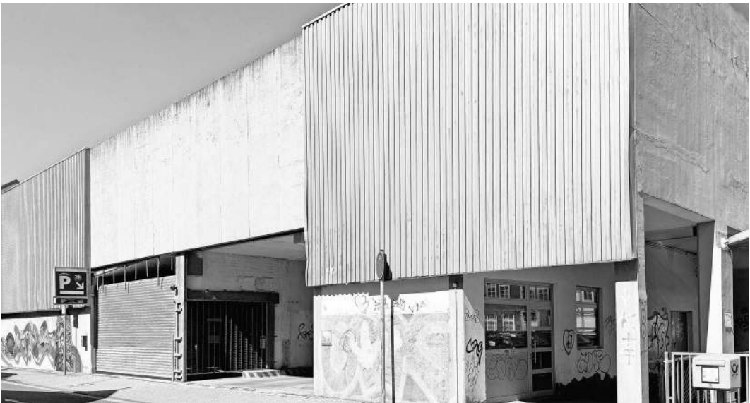
Unter neuer Regie: das einstige Karstadt-Parkhaus am Südwall. Foto: Stadt Celle
