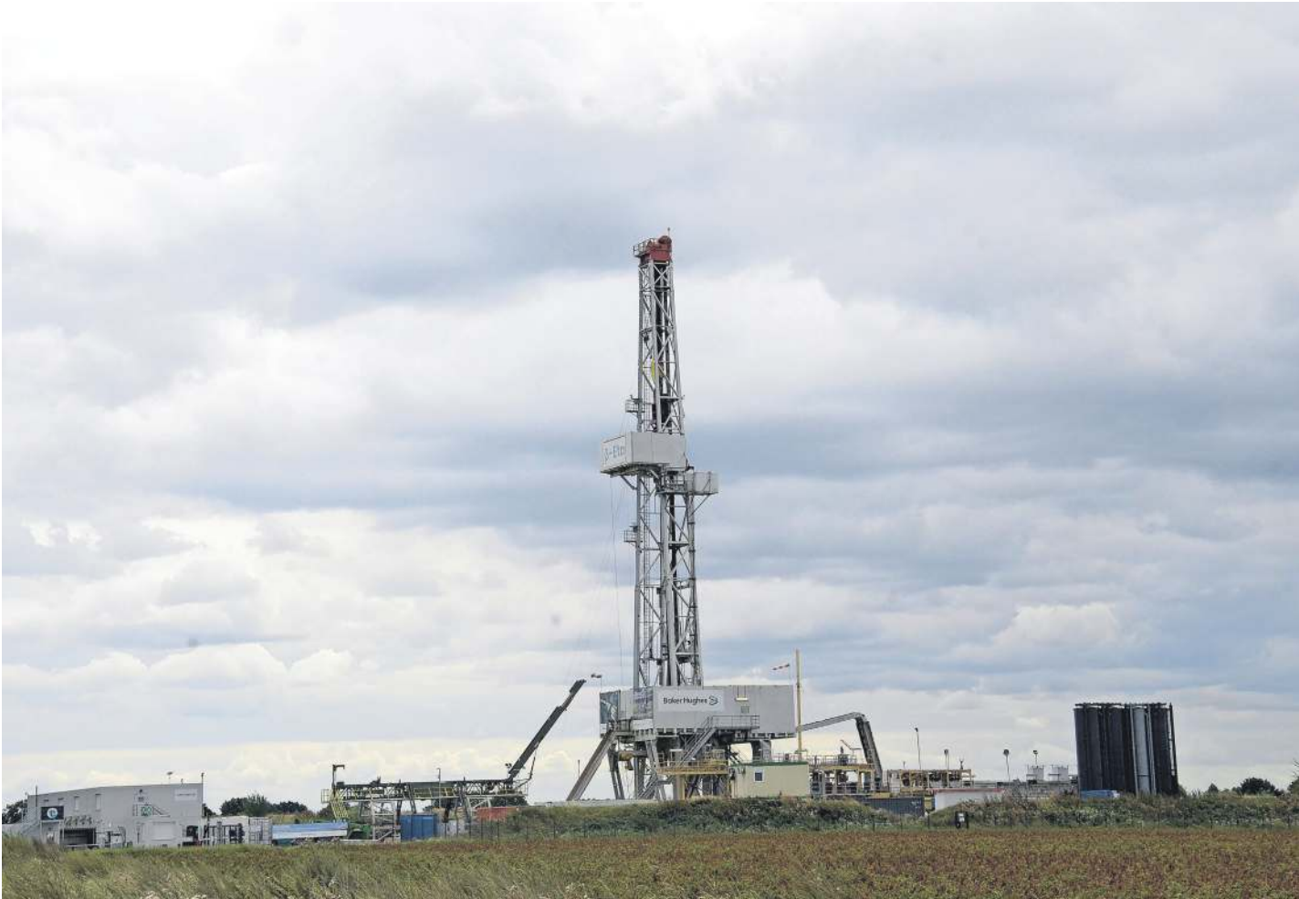
Die Tiefenbohrung von Baker Hughes bei Ahnsbeck.
