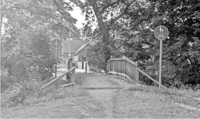
Noch mit abgestütztem Geländer, bald mit geringem CO 2 -Fußabdruck: die Brücke in Klein Hehlen. Foto: Stadt Celle
