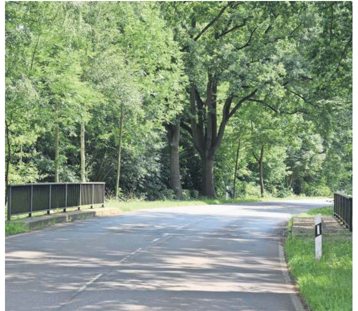
Auch die Brücke zwischen Hohne und Spechtshorn auf der Kreisstraße K 46 wird instandgesetzt. Foto: Müller
