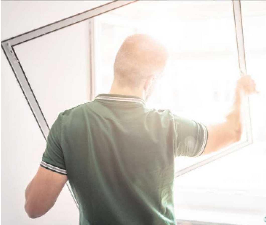
Professionell installierter Insektenschutz lässt im Sommer frische Luft ins Haus und hält Mücken, Wespen oder Fliegen zuverlässig draußen. Foto: Anselm/AdobeStock/BVRS
