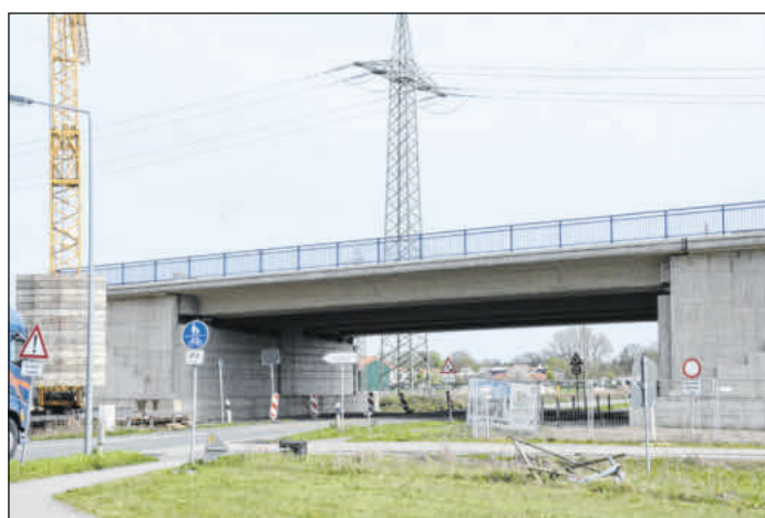
Die Brücke am Baker-Hughes-Kreisel ist fertig.
