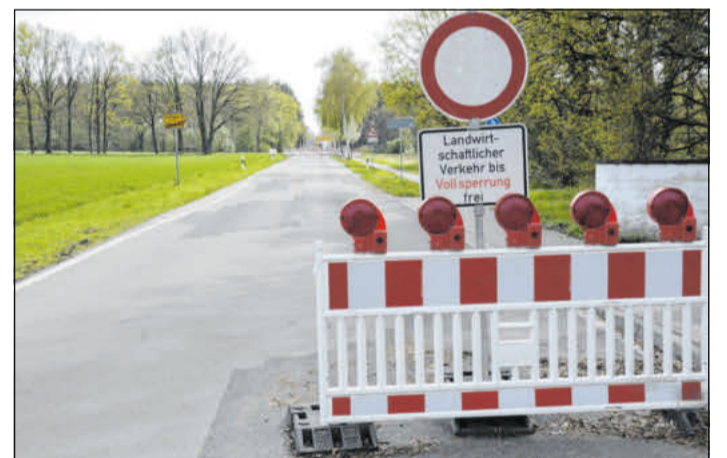
Die Brücke zwischen Burg und Nienhagen wird wohl erst im Spätsommer fertig.
