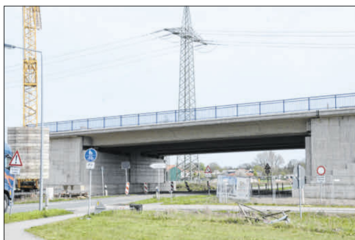
Die Brücke am Baker-Hughes-Kreisel ist fertig.
