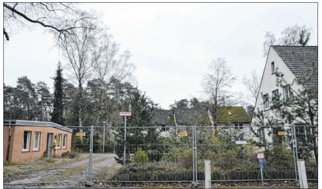
In Westercelle beginnen noch in diesem Jahr die vorbereitenden Arbeiten zum Bau des Staatschutzsenats. Foto: Kirakossjan
