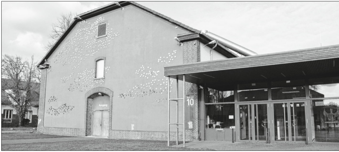
Der Haushaltsausschuss des Bundes hat 2.568.751 Euro für die Sanierung der CD-Kaserne in Celle bewilligt.
