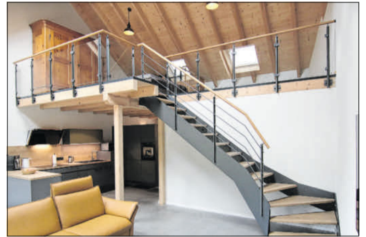
Passt ausgezeichnet in ein modernes Ambiente: die HPL-Wangentreppe mit Relinggeländer und rundem Handlauf. Foto: epr/Kenngott
