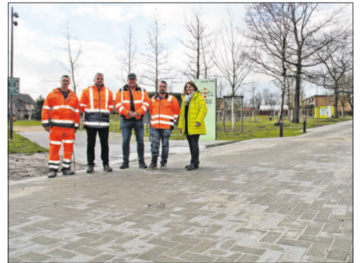
Bauabnahme am Spielplatz Danziger Straße. Foto: Stadt Bergen
