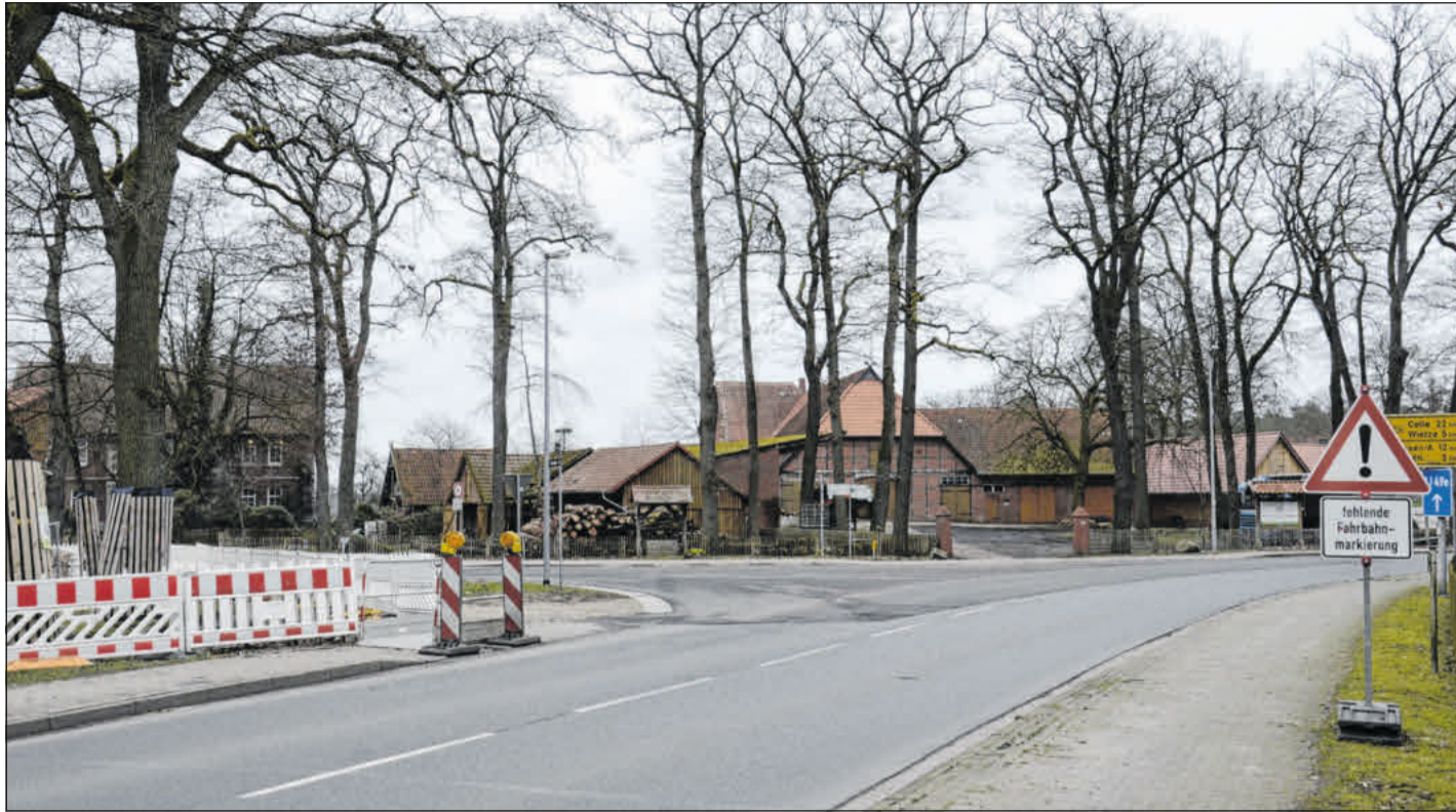
Am Montag, 26. Februar, wird die Baumaßnahme Ortsdurchfahrt Jeveresen fortgesetzt.
